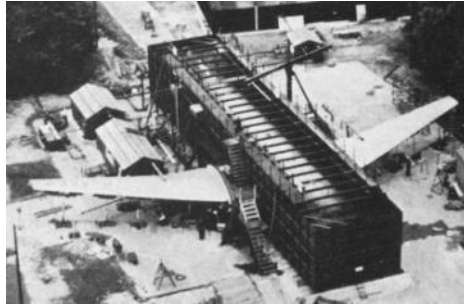
Figure 2. Essai de fatigue sur le COMET ( http://jn.passieux.free.fr/html/Comet_1.php )
